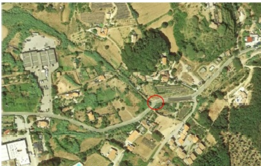
Figura 2 - immagine satellitare che evidenzia (cerchio rosso) l'area affetta da un'accelerazione delle deformazioni della sede stradale.
